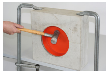
Rompere la membrana interna della flangia
