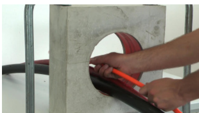
Inserire i cavi all'interno della flangia
